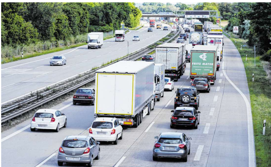
Eine der großen Herausforderungen für die neue Autobahn GmbH: der Umbau des Walldorfer Kreuzes (hier von der A 6 kommend). BILD: DPA
