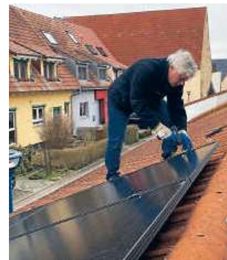
Dieter Riedel bei der Montage seiner Anlage. Foto: Solardrom
